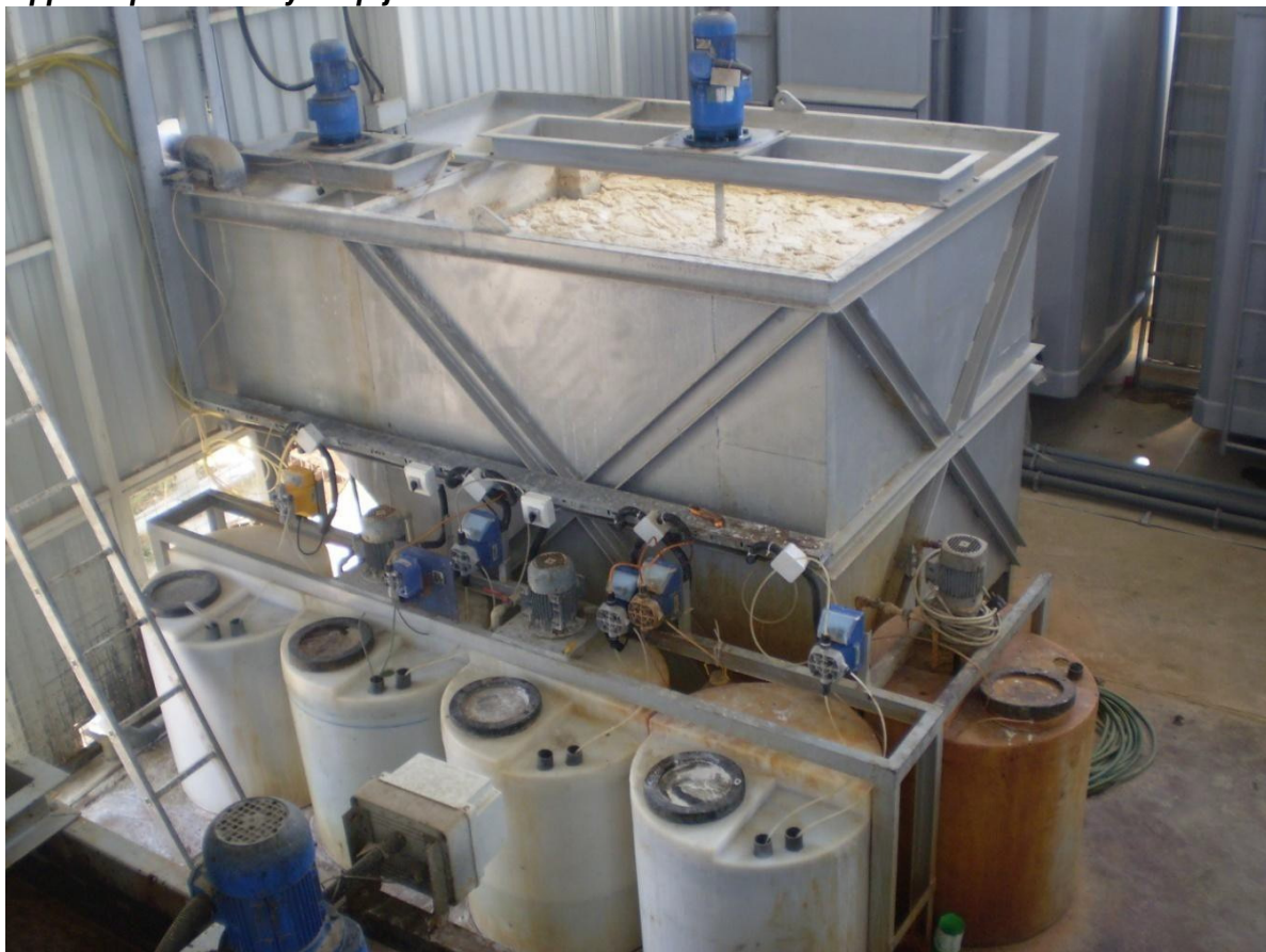
Слика бр. 16 Единица за коагулација и флотација на вакуумска вода
